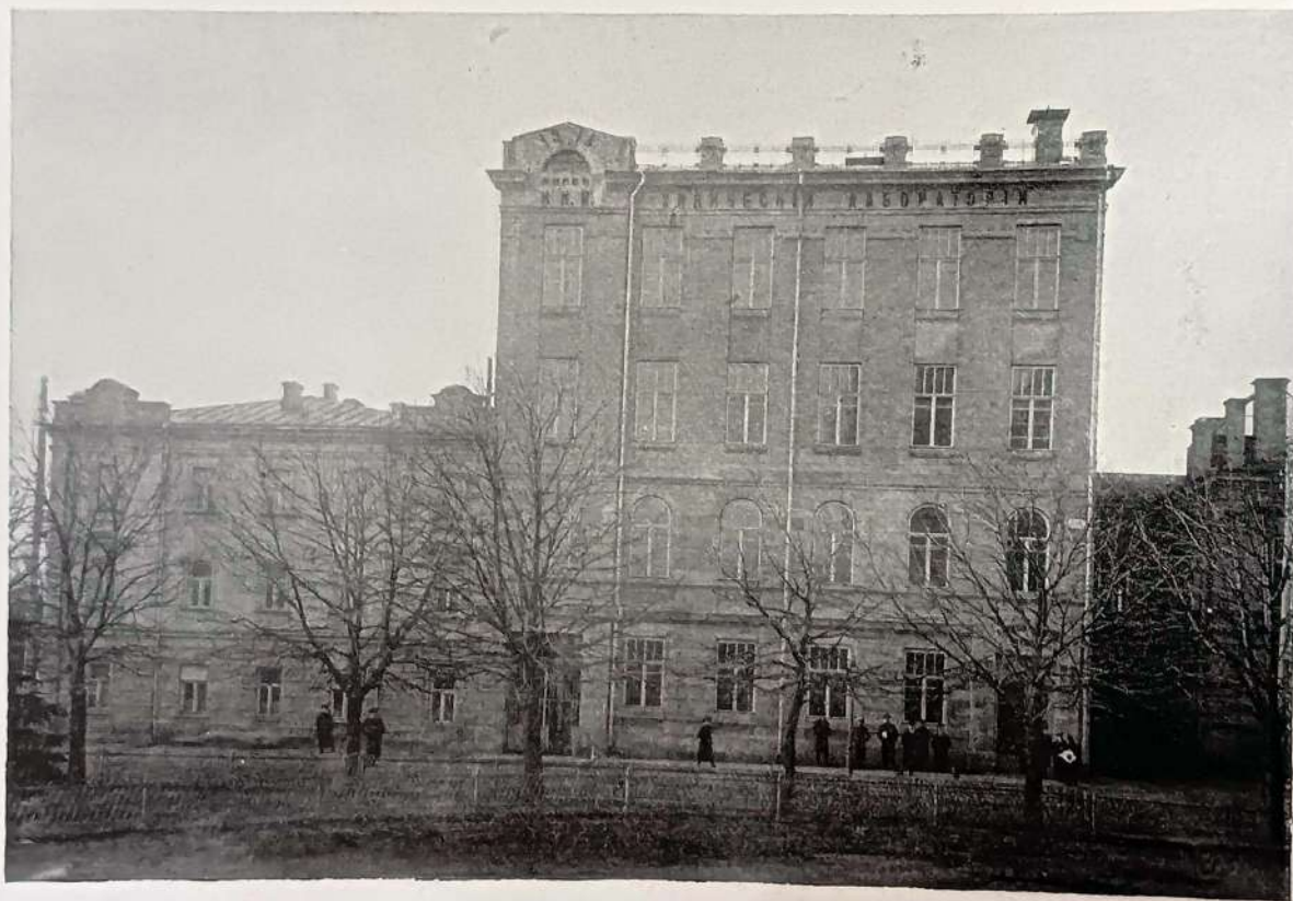
Façade des laboratoires.
