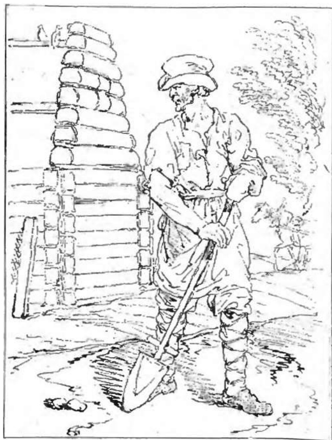
За земляными работами (Аткинсонъ).
